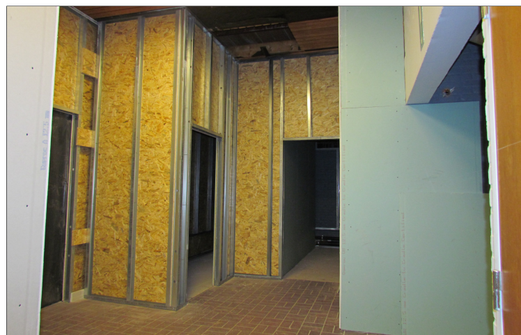
In 2015 werd ook een schitterend toilettenblok toegevoegd
